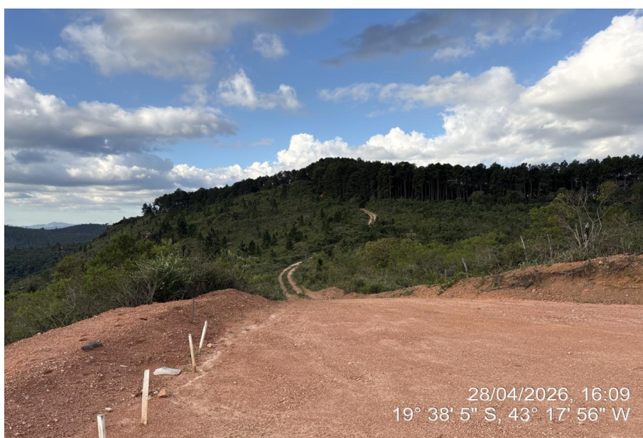
Figura 15: Registro fotográfico das vias de acesso.
