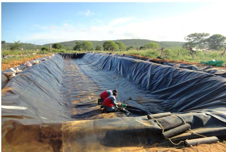
Figura 8.61 - Impermeabilização de tanques de piscicultura<sup>35</sup>.
